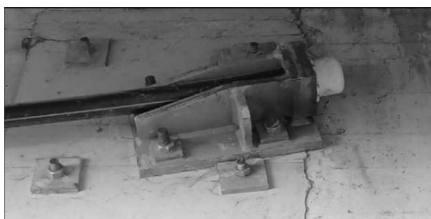
Dettaglio "cap" testata precompressione esterna
