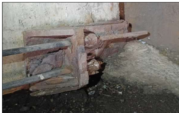
Figura 104: Esempio di condizioni di conservazione favorevole all'applicabilità della prova diretta (prima foto da sinistra) e di conservazione sfavorevole (seconda foto da sinistra)
