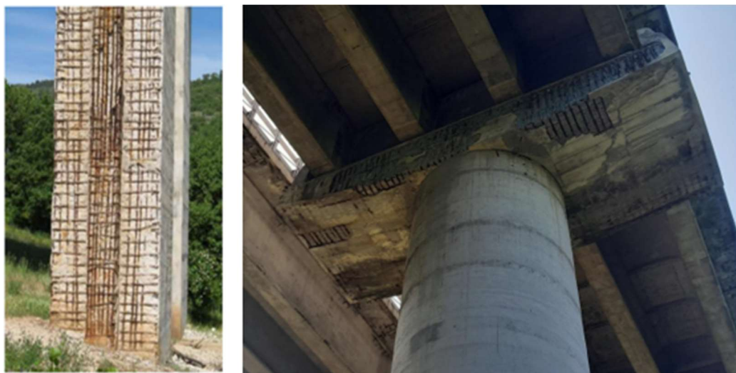
Figura 17 – Esempio di restituzione- Identificazione del difetto esteso
