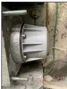
Dettaglio "cap" testata precompressione esterna con calotta in polietilene
