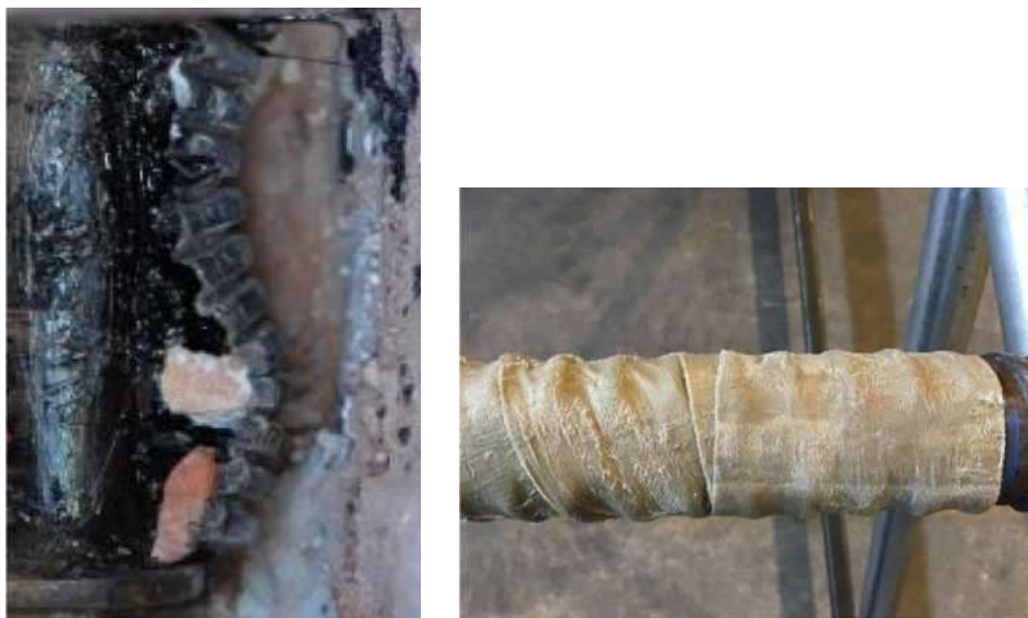
Figura 136: Riempimento protettivo catramato e con fascia paraffinosa
