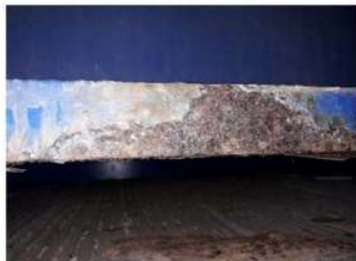
Ossid. e corrosione piastre e lamiere
