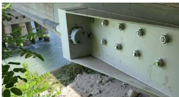
Dettaglio ancoraggio a 7 trefoli con "cap" in polietilene su cavo a trefoli iniettati in opera con boiacca di cemento (dopo tesatura)
