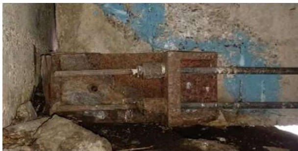
Dettaglio testata precompressione esterna realizzata con ancoraggio monotrefolo
