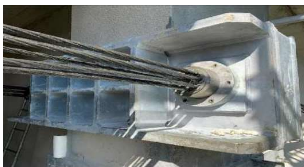
Dettaglio ancoraggio a 9 trefoli con "cap" lungo in acciaio
