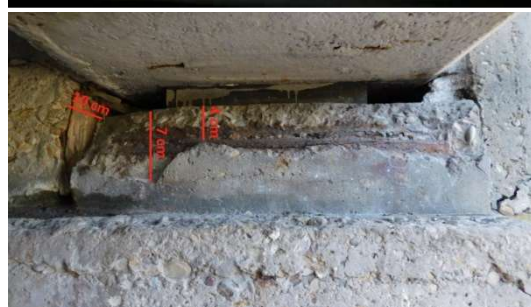
Figura 20 - Esempio di restituzione con rappresentazione delle misure indicate su foto del difetto
