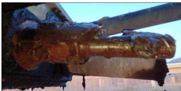
Dettaglio testata precompressione esterna realizzata con barra Macalloy protetta con calotta in acciaio riempita con grasso
