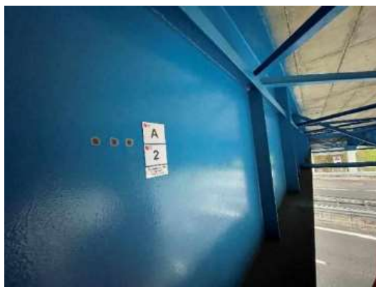
Figura 60 – Esempio di restituzione dati – Prove spessimetriche su carpenteria metallica
