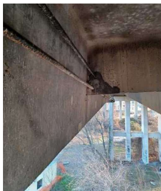
Figura 113: Esempio di postazione di acquisizione sul bordo interno della trave di bordo
