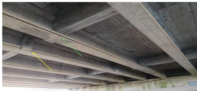
Figura 110: Esempio di possibili interferenze con la lunghezza libera vibrazionale
