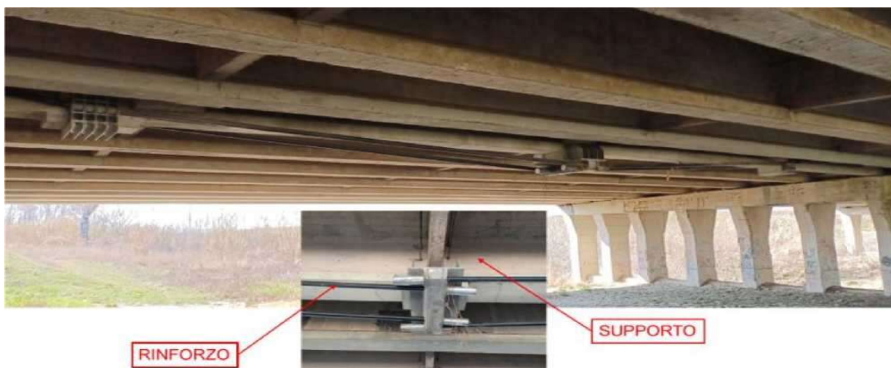
Figura 97: Identificazione delle componenti del Sistema di Precompressione Esterna
