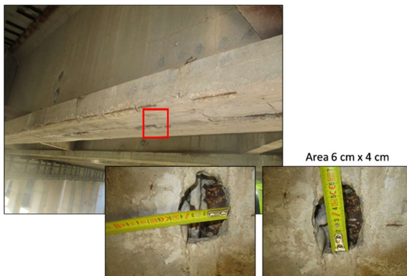
Figura 16 – Esempio di restituzione- Identificazione e misurazione del difetto localizzato
