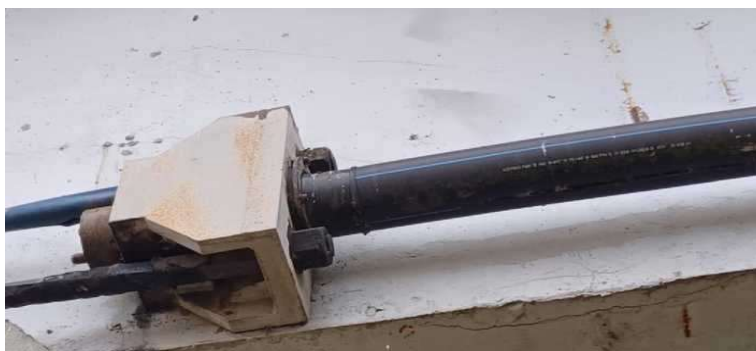
Figura 130: Tubo esterno di rivestimento protettivo con guaina in polietilene
