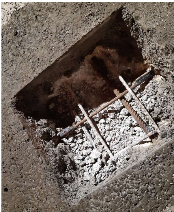
Figura 38 – Saggio in estradosso soletta con rimozione pavimentazione
