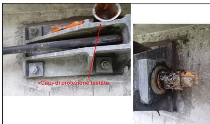
Figura 103: Esempio di rimozione protezione di testata e dettaglio Barra Dywidag con grasso protettivo
