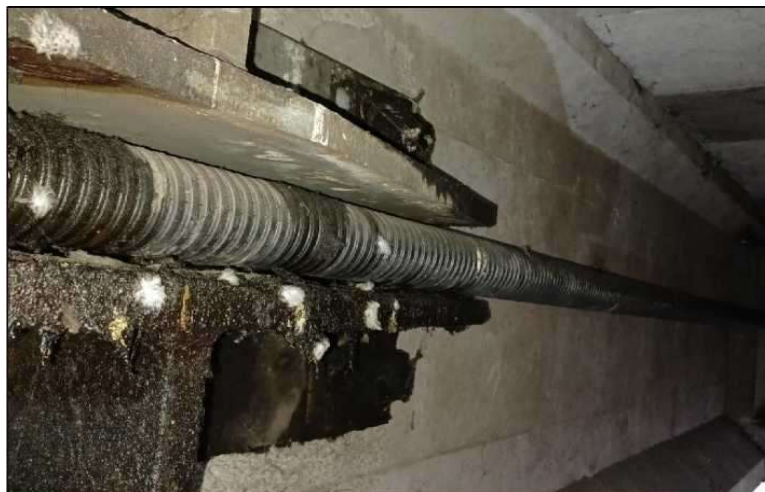
Figura 131: Tubo esterno di rivestimento protettivo in plastica
