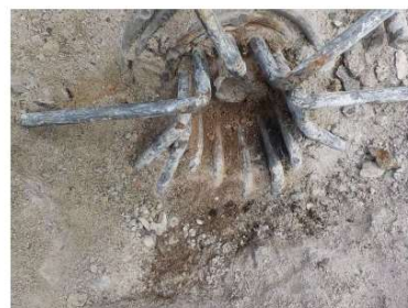
Figura 71 – Identificazione del sistema di precompressione - Esempio di restituzione rilievo testate ancoraggio (armatura post-tesa)
