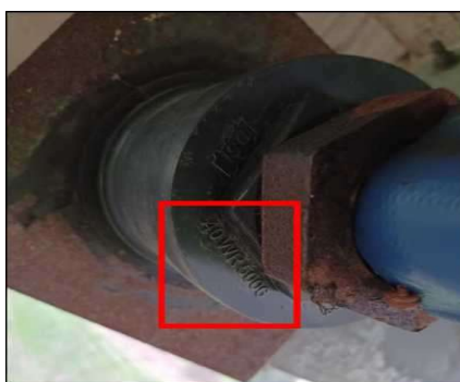
Figura 98: Esempio dettaglio marcatura da cui ricavare caratteristica della barra (tirante in generale)
