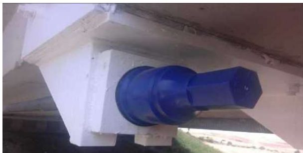
Dettaglio ancoraggio barra Dywidag con calotta in polietilene
