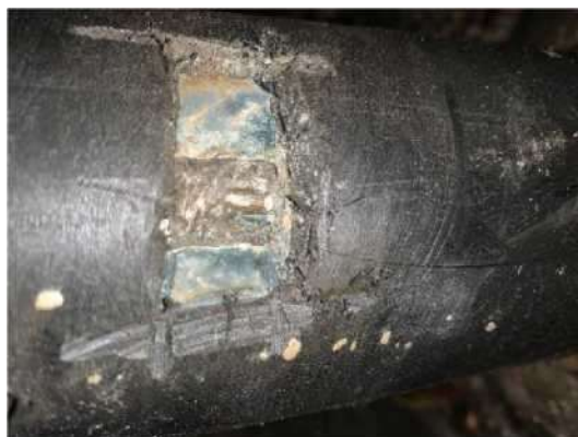
Figura 138: Cavo con trefolo viplato ed iniezione della guaina con boiaccia di cemento
