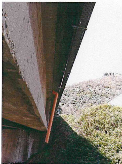
Immagini sistema di smaltimento delle acque
